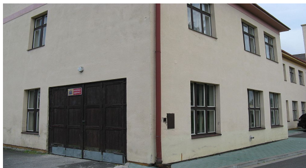
Stav před opravou
