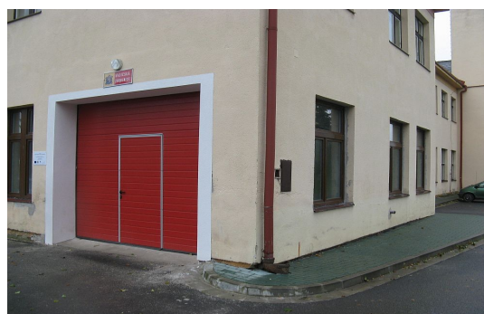
Stav po opravě
